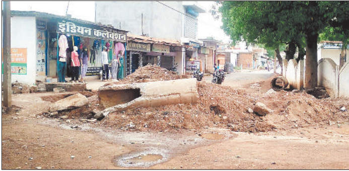
सड़क निर्माण के लिए खोदा गया गड्ढा।
